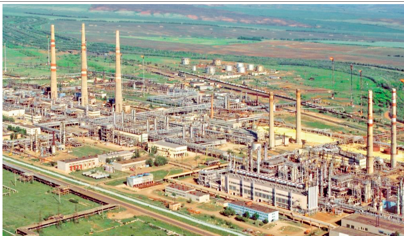
Рис. 2. Оренбургский газоперерабатывающий завод
