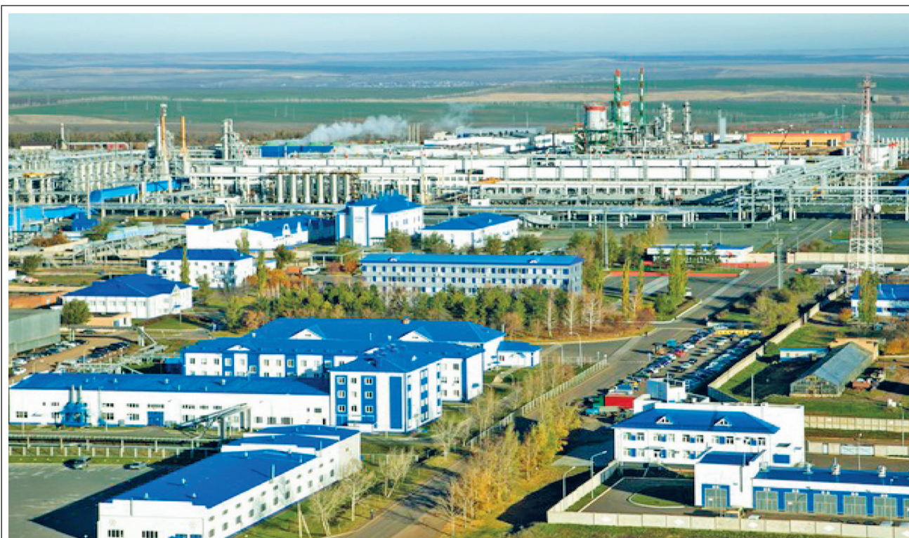
Рис. 1. Оренбургский ГПК — газоперерабатывающий и гелиевый заводы
